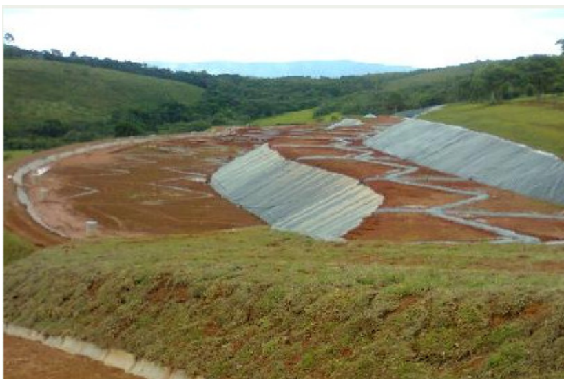
Foto 04: UTR-Aterro Sanitário Ecotres. Frente de operação 1ª fase. (vista parcial).
