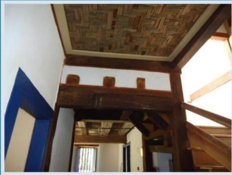
Cômodo da edificação com 19,55 m<sup>2</sup> destinado a circulação com acesso a 3 salas, bloco assobrado e a escada para o 2º pavimento. Como revestimento, apresenta piso em tabuado de madeira, forro de esteira em 02 tons de bege e cobertura em telha vã com engradamento em madeira. A estrutura, GUARDA-CORPO e degraus da escada são em madeira, no patamar da escada encontramos uma luminária e a janela de prospecção mostrando a vedação da edificação.
