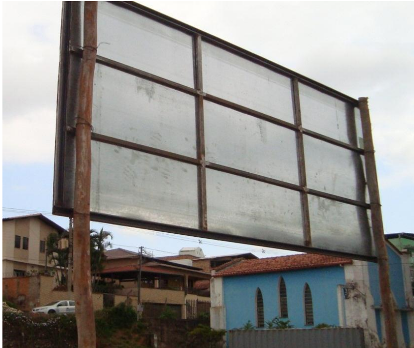
Figura 2-Fundo e estrutura da placa Dimensões placa: 3,00 x 1,50m
