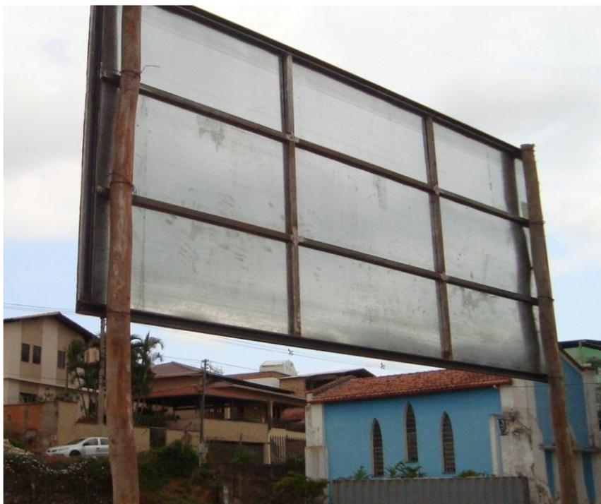
*Figura 2-Fundo e estrutura da placa Dimensões placa: 3,00 x 1,50m*
