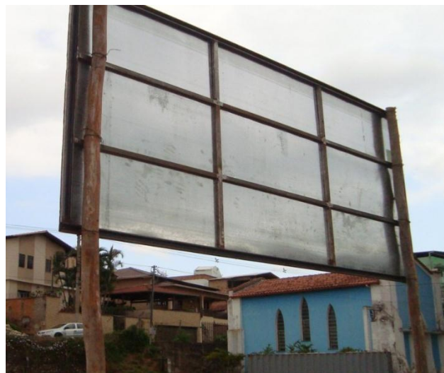
Figura 2-Fundo e estrutura da placa Dimensões placa 5m 2
