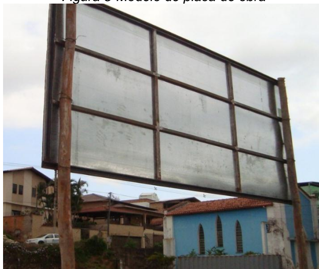
Figura 6-Fundo e estrutura da placa Dimensões placa 5m²
