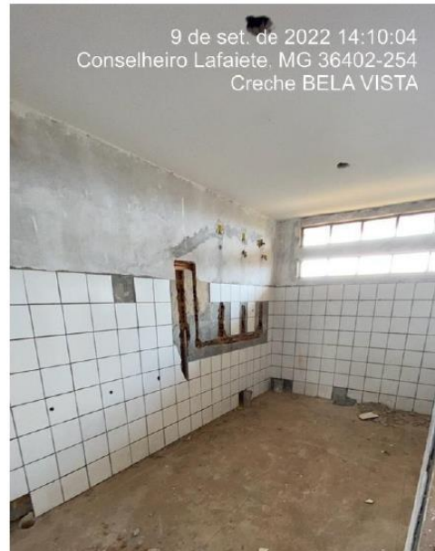
Figura 10 - Vista interna banheiros
