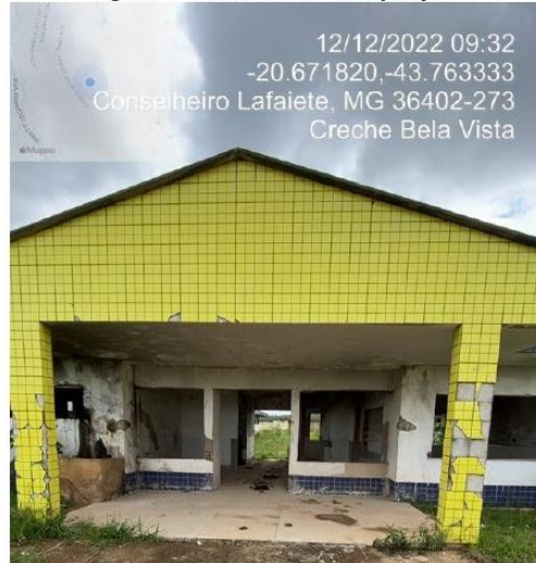
Figura 5 - Vista frontal da edificação
