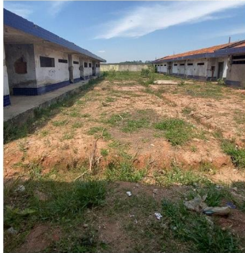
Figura 2 - Vista do pátio interno
