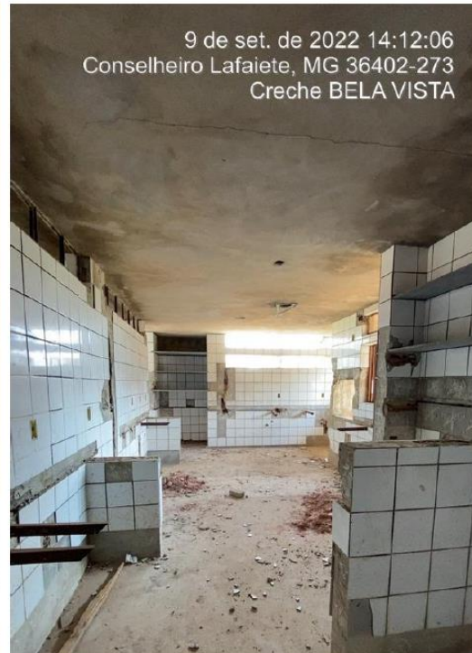
Figura 13 - Vista interna cozinha
