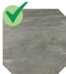
piso de concreto
